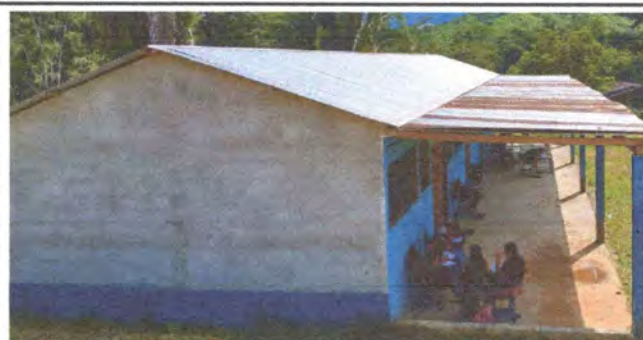
Foto 5: Aplicación a dos manos de pintura en exterior del establecimiento.
