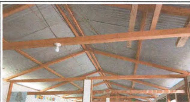
Foto 2: Montaje, instalación y suministro de estructura metalica y laminas troqueladas.
